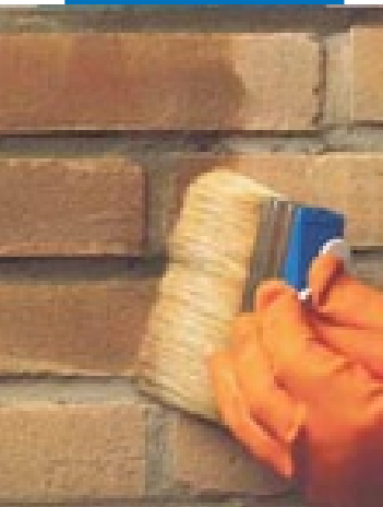
Нанесение Antipluviol S кистью
